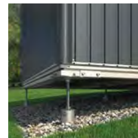
Výškové vyrovnanie zemnými skrutkami
